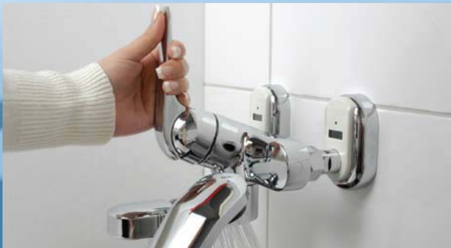
Nicht grösser als eine Zigarettschachtel: der Wasserkostenverteiler mit Kompaktelektronik
